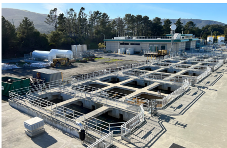
Depósitos de filtración de la HTWTP
