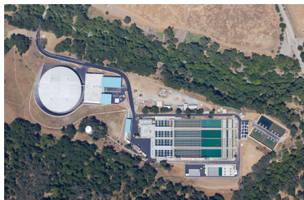
Vista aérea de la SVWTP
