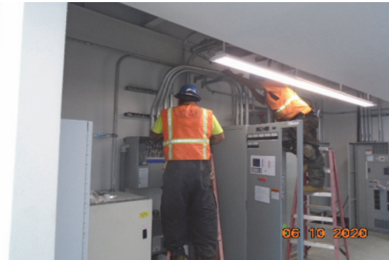
SEP 522 New Conduits and Wiring
