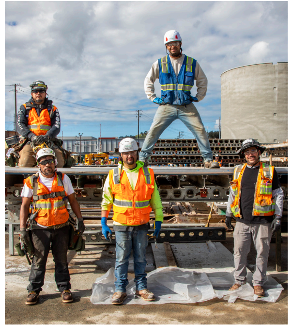
工作人員正在稍作休息，準備將重達 6 萬磅的鋼蓋吊裝到生化廢料消化池上。
