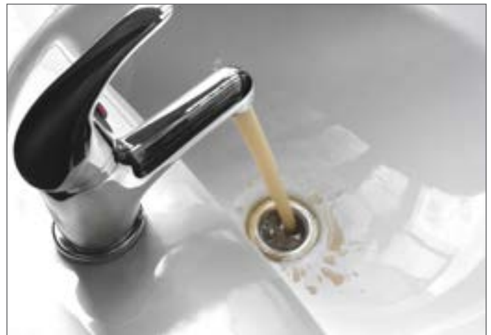
Agua con color de un grifo después de una rotura en la tubería principal.
