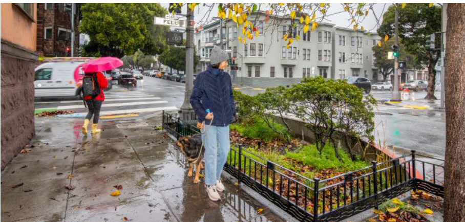
Wiggle 鄰里綠色走廊雨水花園 - Wiggle 鄰里綠色走廊計劃每年處理 120 萬加侖雨水。圖片位置: Fell Street 與 Broderick Street。
